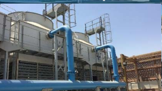
محطة تبريد - CFC (٢١.٠٠٠ طن تبريد)
